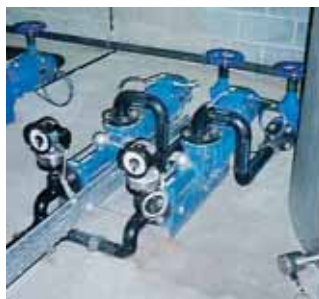
Насосы seerex BN 2-6L. Продукт: раствор флокулянта к обезвоживающим машинам.
