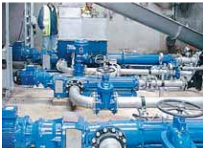
Насосы seerex BT 70-12 и BN 52-6L. Продукт: импортированный обезвоженный шлам с 30% сухого остатка и первичный шлам примерно с 1 - 2% сухого остатка. Особенность: обратное перемешивание импортированного шлама с первичным шламом примерно до 6% сухого остатка и дальнейшая транспортировка к септической камере. Первичный шлам подается сбоку в загрузочную воронку.
