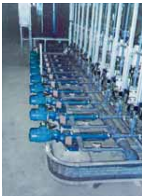
Насосы seepex BN 1-6L . Продукт: раствор флокулянта Флокулянт дозируется в сгуститель.
