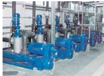
Насосы seerex BN 130-6L с предвключенными мацераторами seerex U 110. Продукт: избыточный шлам.
