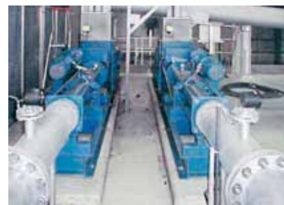
Насосы сеерех TINS 70-24. Продукт: обезвоженный шлам из центрифуги. Особенность: Обработанный известью в насосе шлам содержит примерно до 40% сухого остатка и транспортируется в бункер для шлама.
